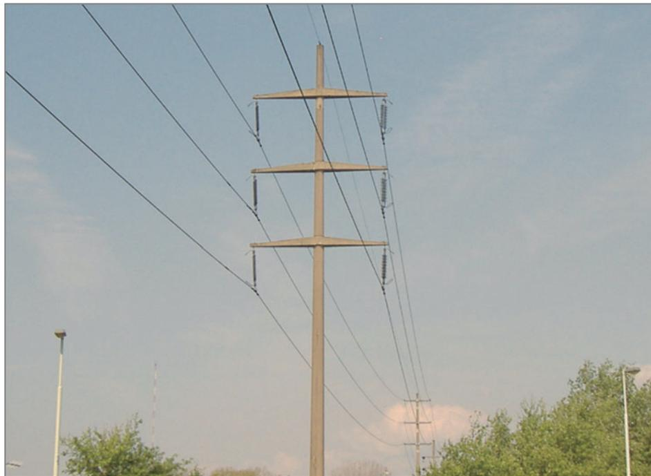
*LA26: Doble terna coplanar vertical, configuración convencional (132 kV)*
